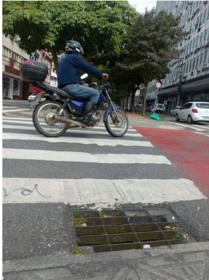
Figura 1 - Bueiro no canteiro central onde é possível ver ou ouvir o rio
